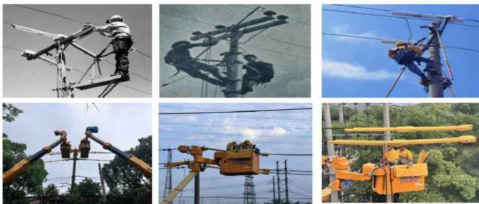
图 1 不同时期和类型的配网不停电作业现场实景
